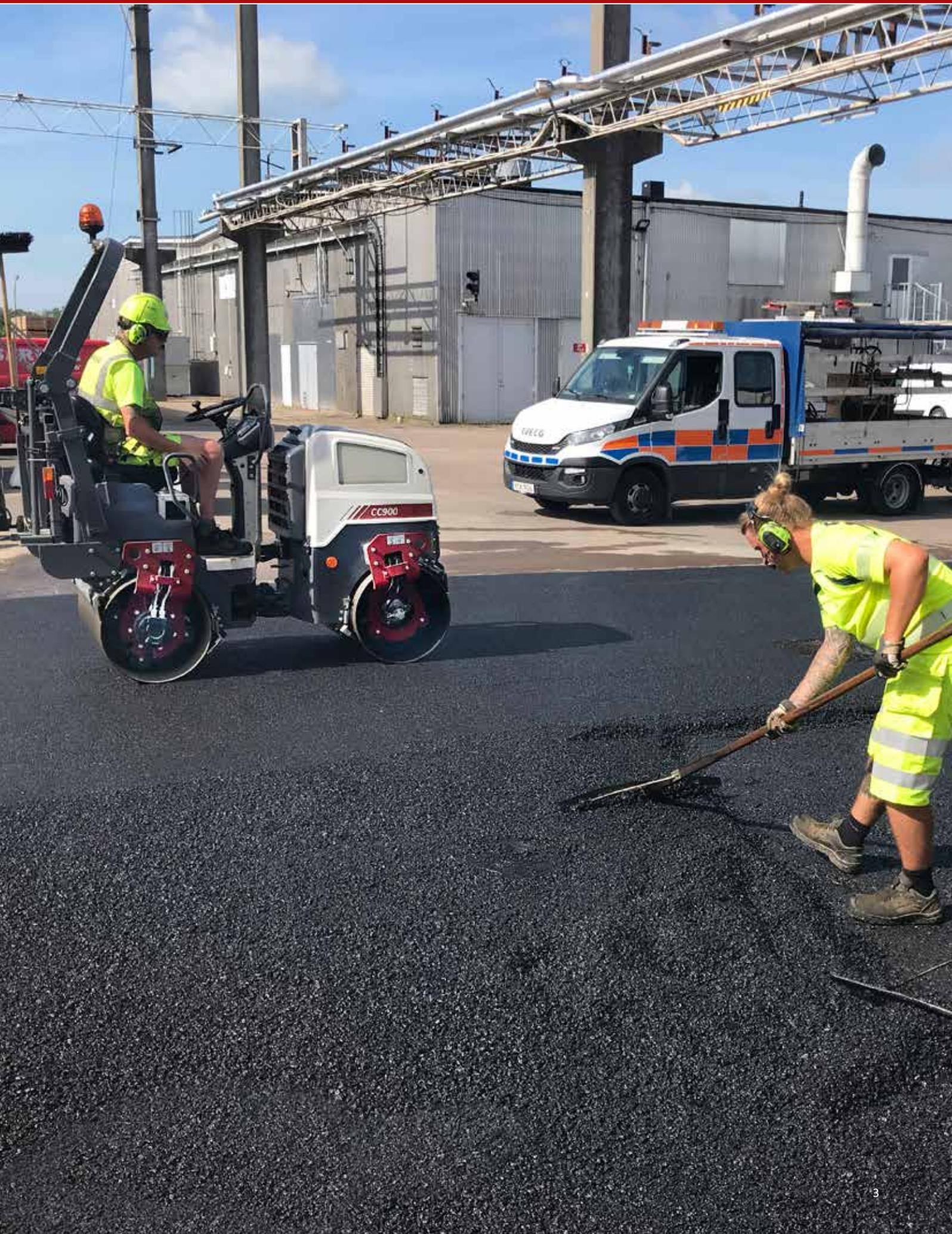
LA GAMMA DYNAPAC di rulli tandem per asfalto – CC800, CC900 e CC1000 – viene utilizzata innanzitutto per lavori di compattazione di minore entità, ad esempio per piste ciclabili, strade piccole, aree di parcheggio e luoghi che richiedono compattazione ma che sono difficilmente raggiungibili con rulli di grosse dimensioni. I rulli di questa serie hanno un peso di esercizio di circa 1,6 tonnellate e larghezze del tamburo rispettivamente di 800, 900 e 1000 mm.
