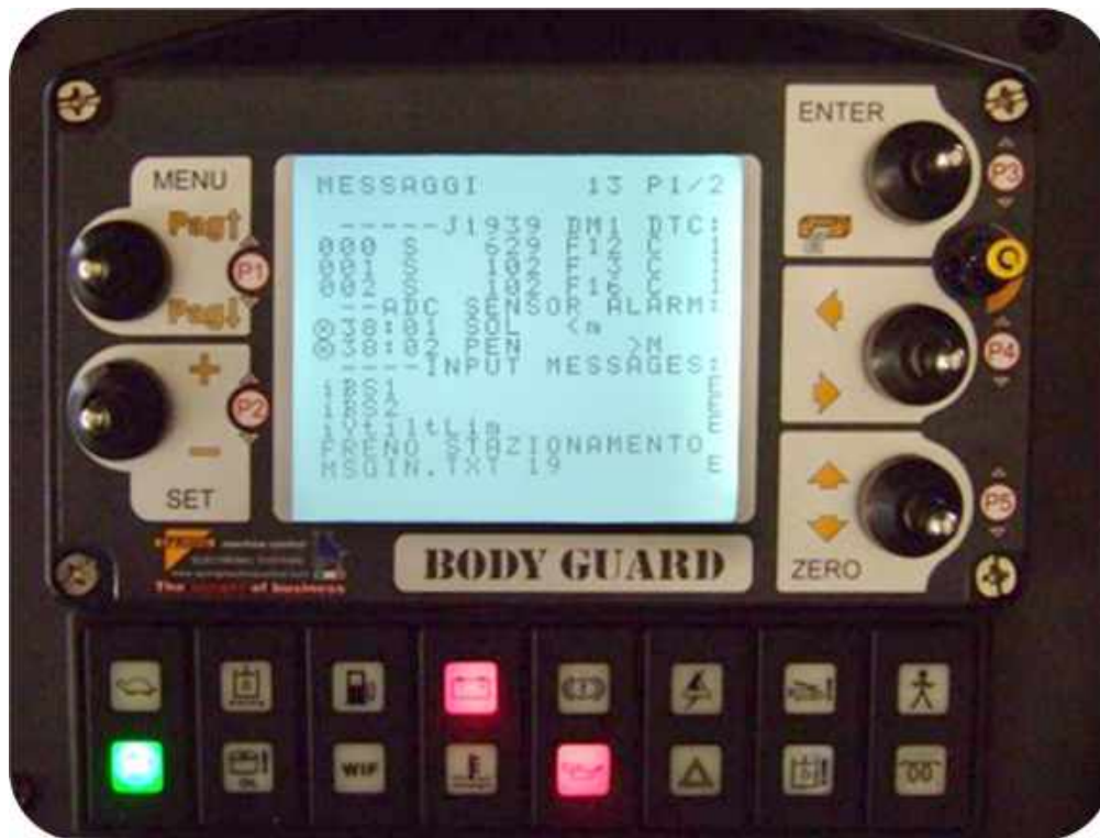
Visualizzazione di errori ed allarmi legati ai sensori e agli ingressi del sistema.
